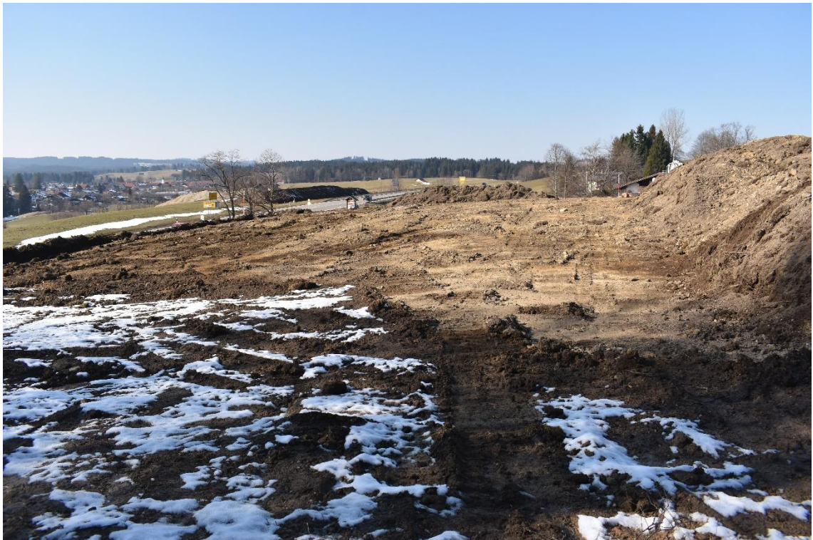
Abb. 2: Blick über abgetragene Fläche (von SO)
