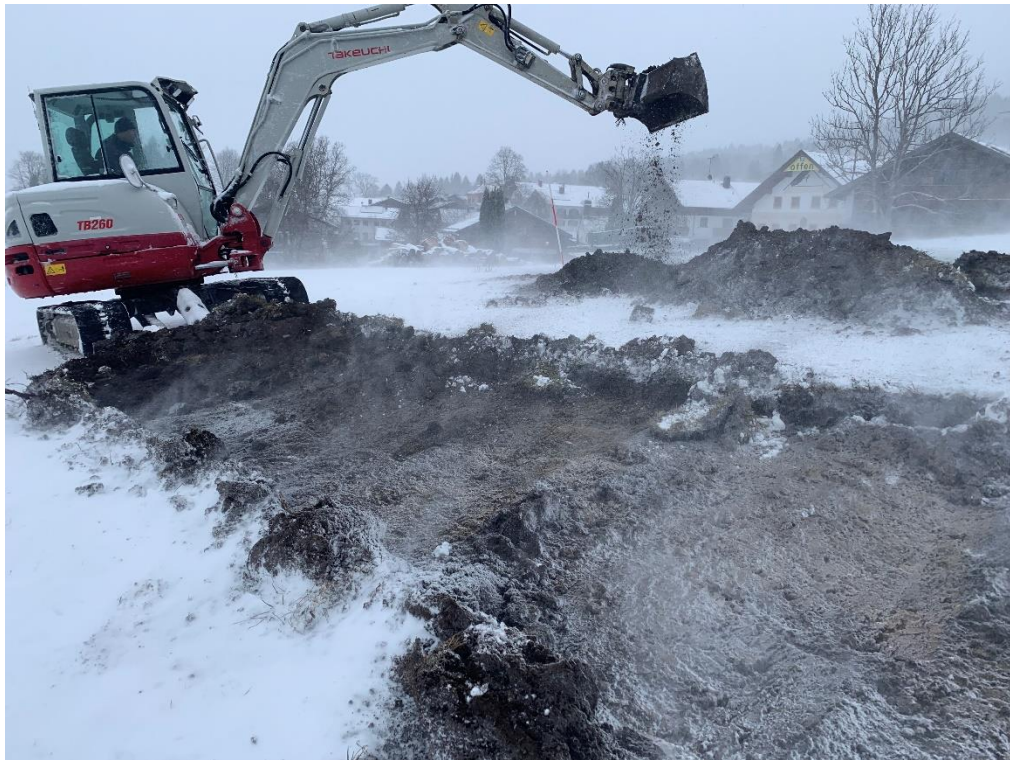
Abb. 1: Oberbodenabtrag am 21.02.22 kurz vor witterungsbedingter Unterbrechung der Arbeiten
